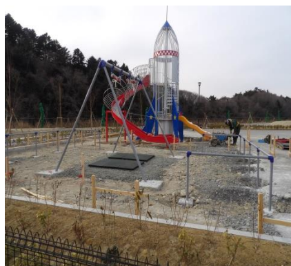
建設中の「空の公園」(5個のうちの1つ)
