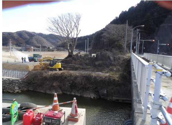
新北上大橋から見た避難しようとした高台
