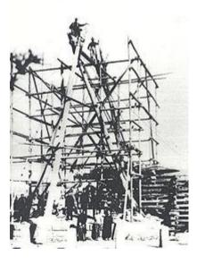
記念碑の復元は、まず、ペンキまみれ泥まみれでひっくり返った碑をきれいにすること。次は、その碑を台座に据える作業。周囲に足場を組み、電柱を4本立て、倒した時と逆順にウインチで引き上げた。最後は、碑を土台に据える接着である。約30 撃ばかりのホゾの隙間に硫黄を流し込んで固めた。立て直した直後の写真を見ると、土台の最上部が新しいコンクリートで固められているのがわかる。
