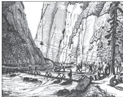
工兵による架橋作業
